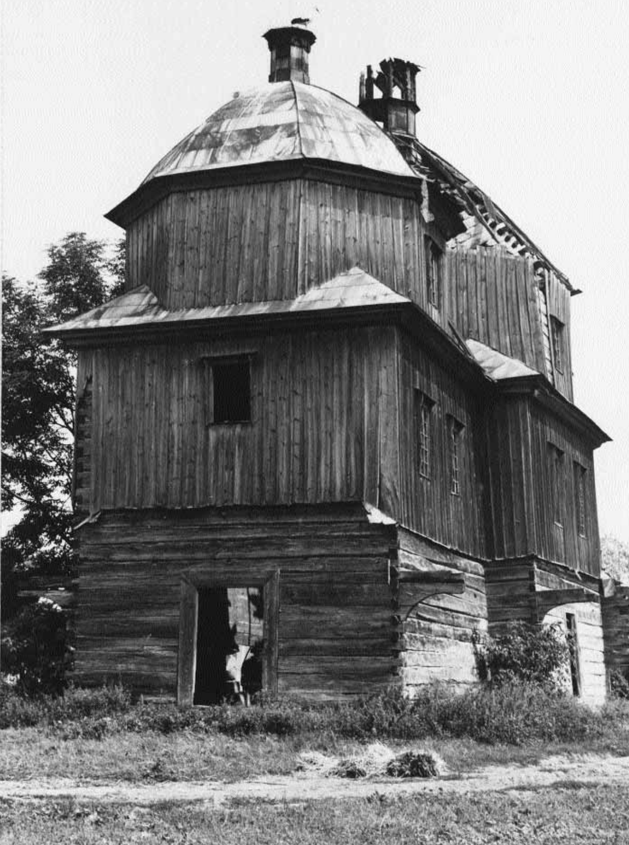
Zniszczona (obecnie już nie istniejąca) drewniana cerkiew greckokatolicka w Wierzbicy (pow. Tomaszów Lubelski) z 1887 r. (na fot. stan z 1984). Fot. – © Andrzej Stepan
