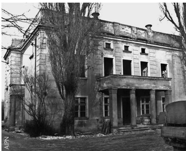
Budynek przy Dworkowej 9 w Poznaniu tuż przed zburzeniem w 1982 r.
