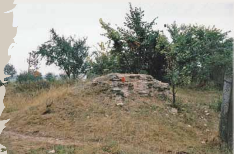
► Wystające z ziemi i obrośnięte elementy fundamentu kościoła w Bereznicy
