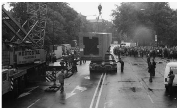
Budowa pomnika na pl. Mickiewicza w Poznaniu
